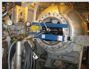
フランジ補修
