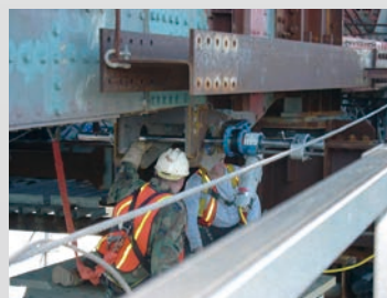
橋梁の鉄骨メンテナンス
