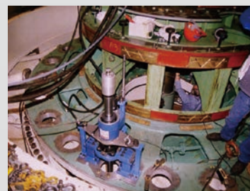
水門の摩耗補修
