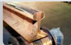
ミリング、及び、グラインディング後のレール開先形状
