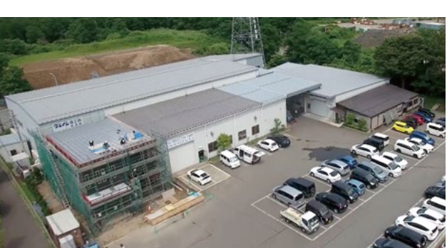
事務所を新設中のタリシ機工製造部
